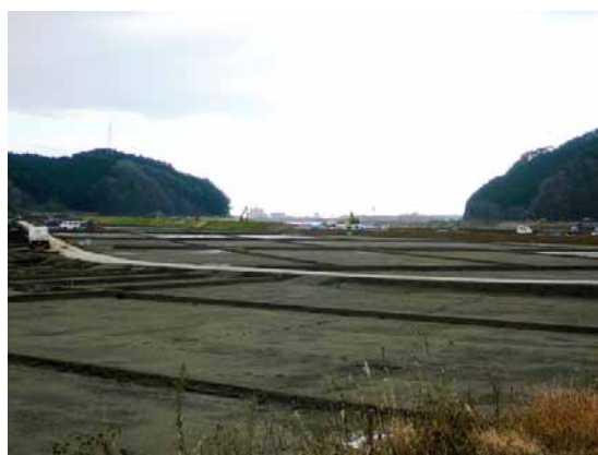
「農地等災害復旧事業」の工事現場
