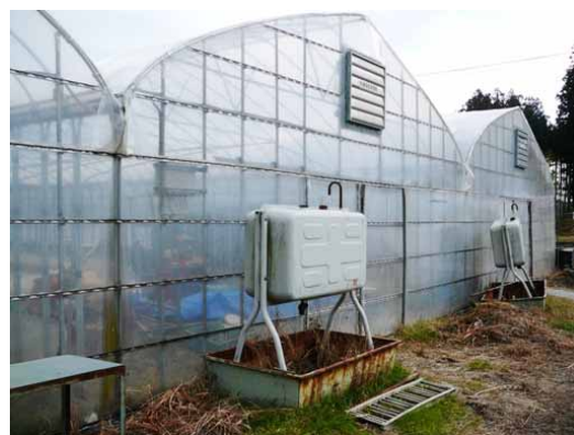
津波の被害から修復した温室
