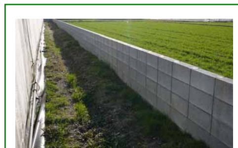
ハウスの外にあるブロック塀
