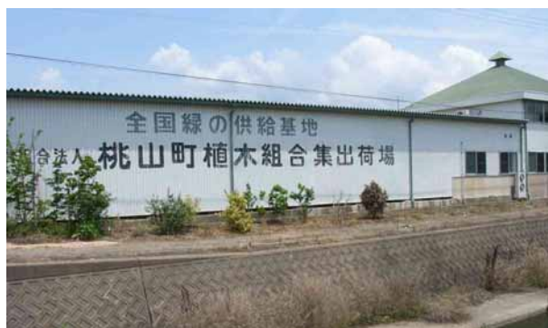
植木組合の倉庫と事務所（右側）
