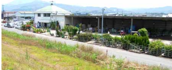
紀ノ川の堤からみた建物全景
