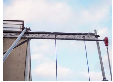
防薬シャッターによるドリフト防止で近隣住宅にも配慮する
