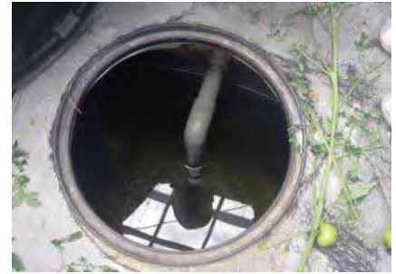
マンホールを開けると豊富な地下水
