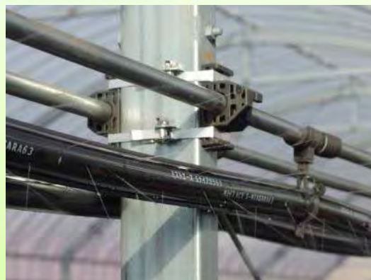
写真2. 灌水チューブ設置状態
