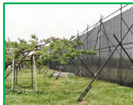
防風ネットの設置状況
