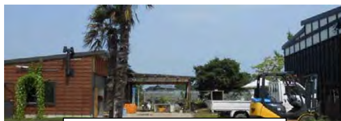
倉庫(右)と建設中の作業場(左)
